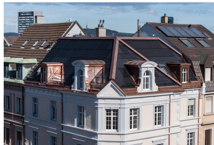
Indach-PV-Anlage bei einem denkmalgeschützten Gebäude
