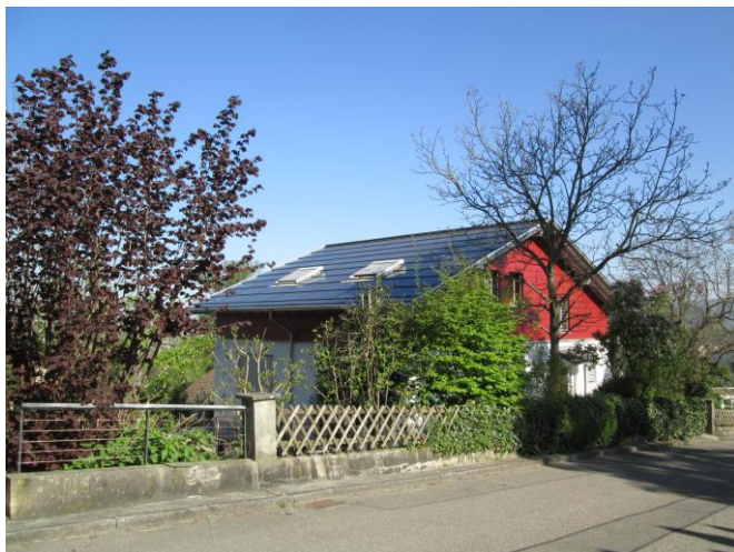
PV-Anlage bei einem Einfamilienhaus
