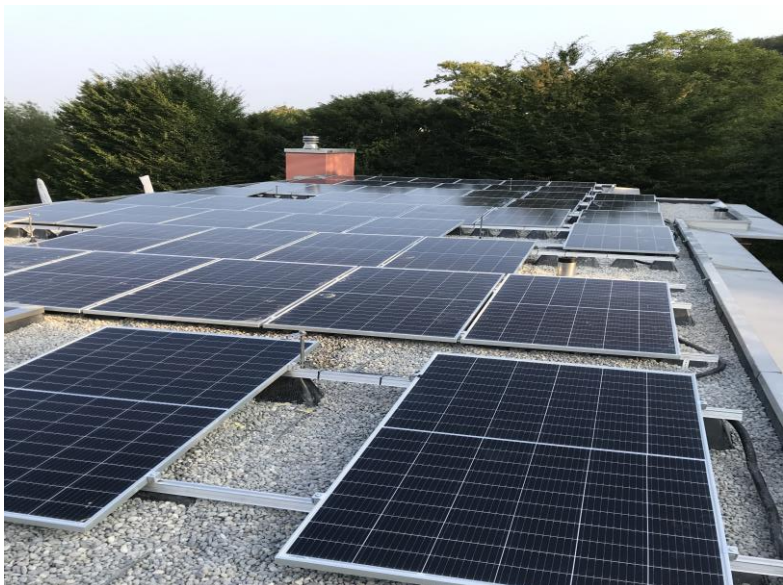
Detail PV-Module auf einem Flachdach
