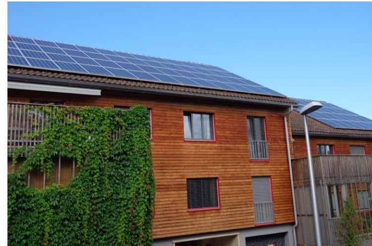
Aufdach-PV-Anlage bei einem Mehrfamilienhaus
