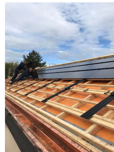
Montage von Indach-Modulen
