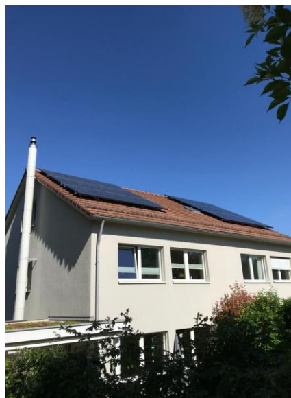
PV-Module Schrägdach
