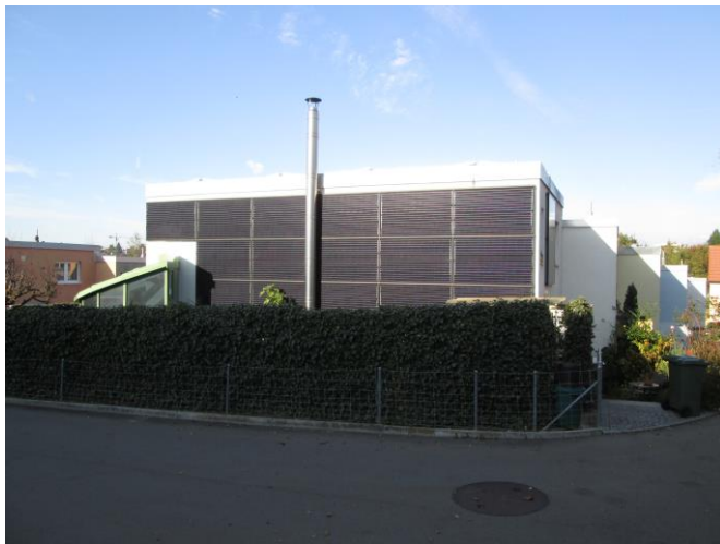
PV-Anlage in die Fassade integriert
